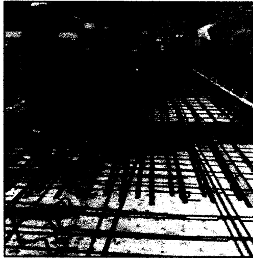
Ilustración 6. Habilitación de acero losa e: 20 cm.
